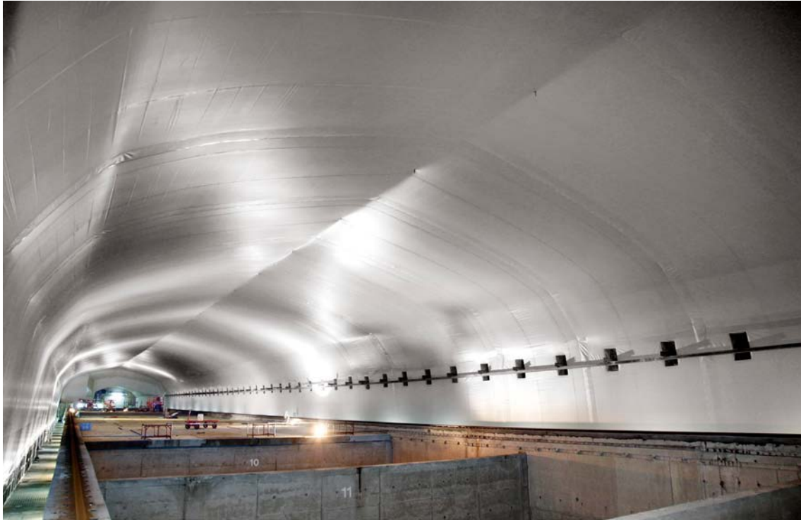
Figur 4-3. Nyligen installerad tunnelduk i befintlig BMA.
