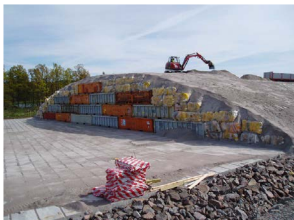
Figur 1. Markförvaret för mycket kortlivat radioaktivt avfall vid Oskarshamns kärnkraftverk (Källa: OKG)
